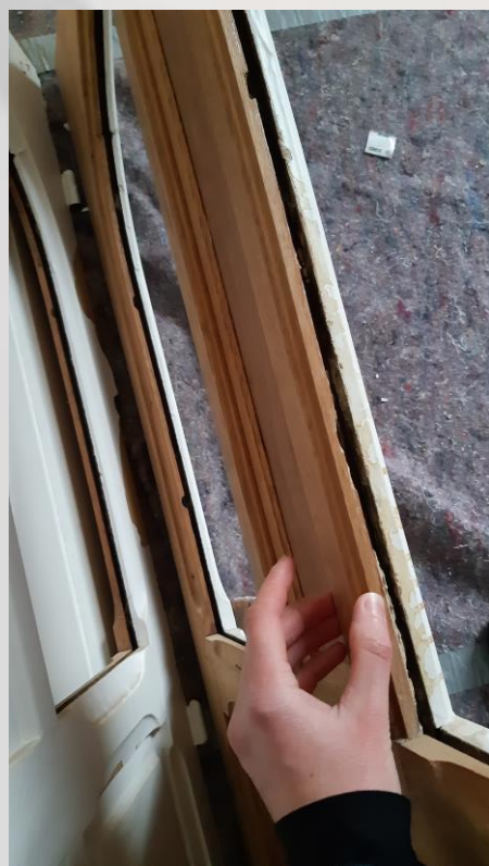
Châssis en bois à parclozes cloutées
